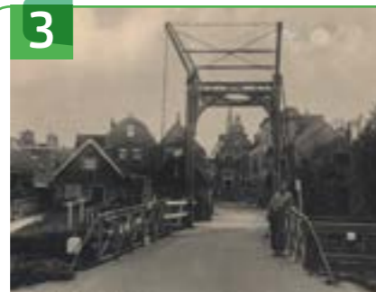
BRUG OVER IJSEL VEERSTRAAT
